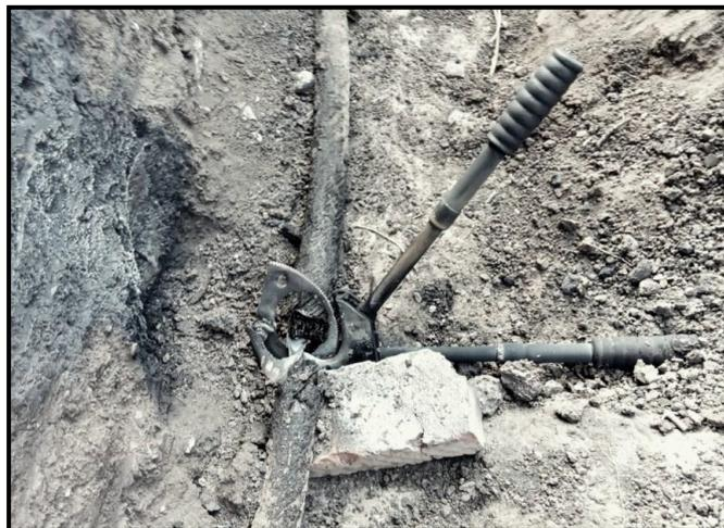
После подготовки рабочего места в 08:35 мастер провёл целевой инструктаж и осуществил допуск бригады в составе: производитель работ и члены бригады (ответственный руководитель работ не назначен). Проверка отсутствия напряжения методом прокола кабеля
