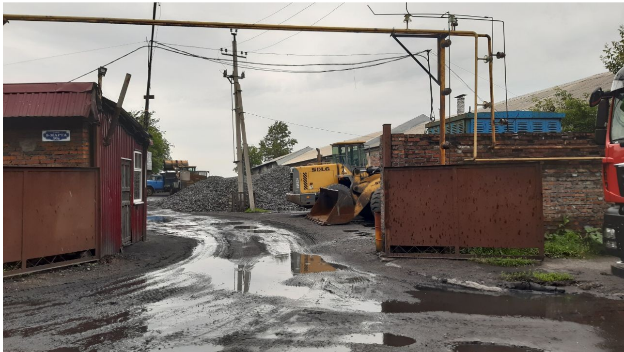
Опора № 7/1 воздушной линии электропередачи 6 кВ Л-815
