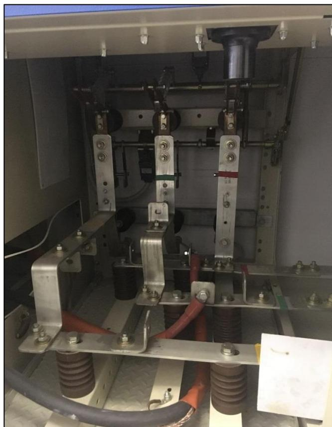
При выполнении работ по распоряжению производитель работ зашёл в БКРУ-6 кВ, чем допустил расширение рабочего места и объёма задания. Открыв двери камеры ввода 6 кВ № 1 (яч. № 5), он проник в опасную зону, допустил прикосновение к токоведущим частям электроустановки, находящимся под напряжением. Вследствие чего он получил поражение электрическим током.
